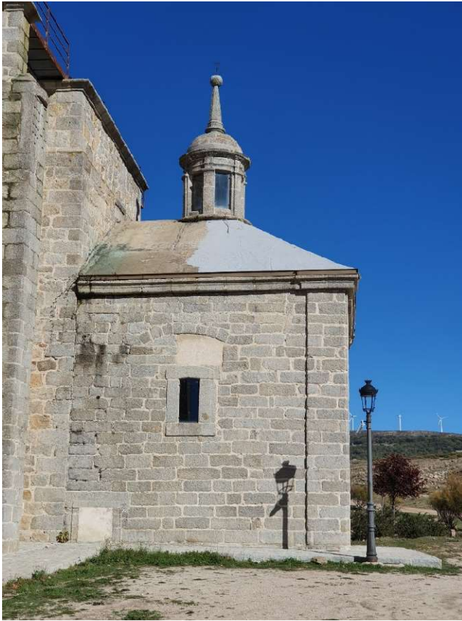
Vista cubierta capilla Sur
