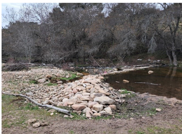
Fotografía de la obra a retirar
