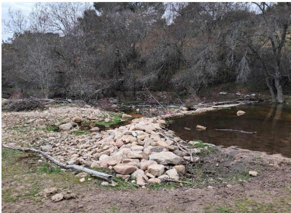
Fotografía de la obra a retirar
