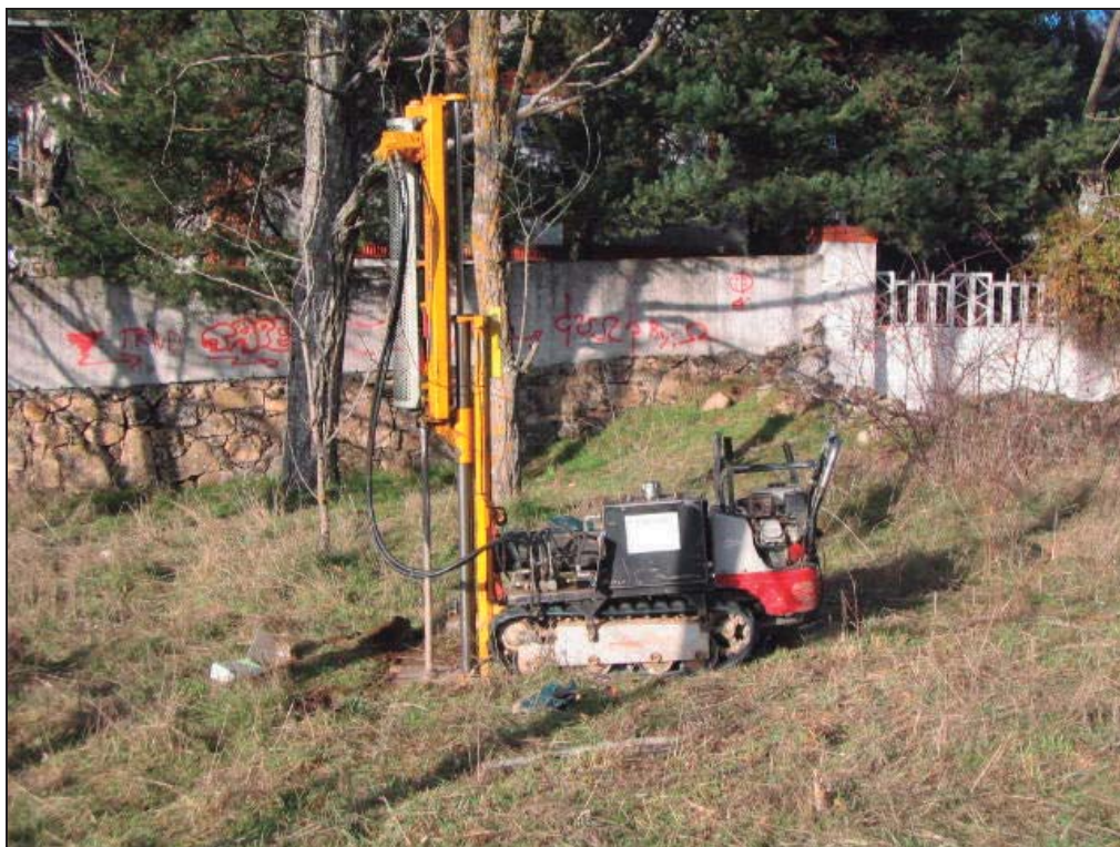
Detalle de ensayo de penetración dinámica tipo Borros.
