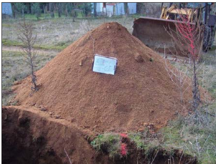
Acopio de los materiales extraídos de calicata C-1.
